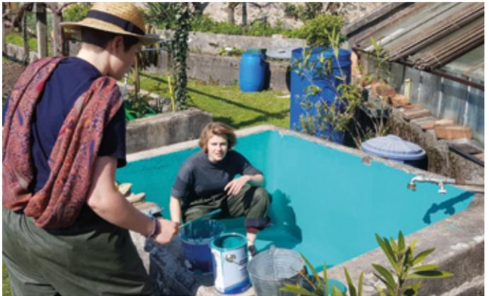
Diese alte Becken wurde gereinigt, verdichtet, gespachtelt und mit der ursprünglichen türkisblauen Farbe bemalt und dient mittlerweile als Wasserreservoir; oder, mit Solarzellen aufgeheizt, als zukünftiger Whirlpool.
